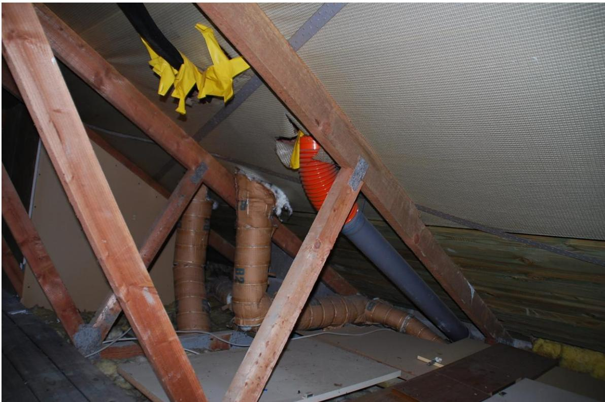
Innenansicht Dach, Binderkonstruktion - Dämmung aufliegend
