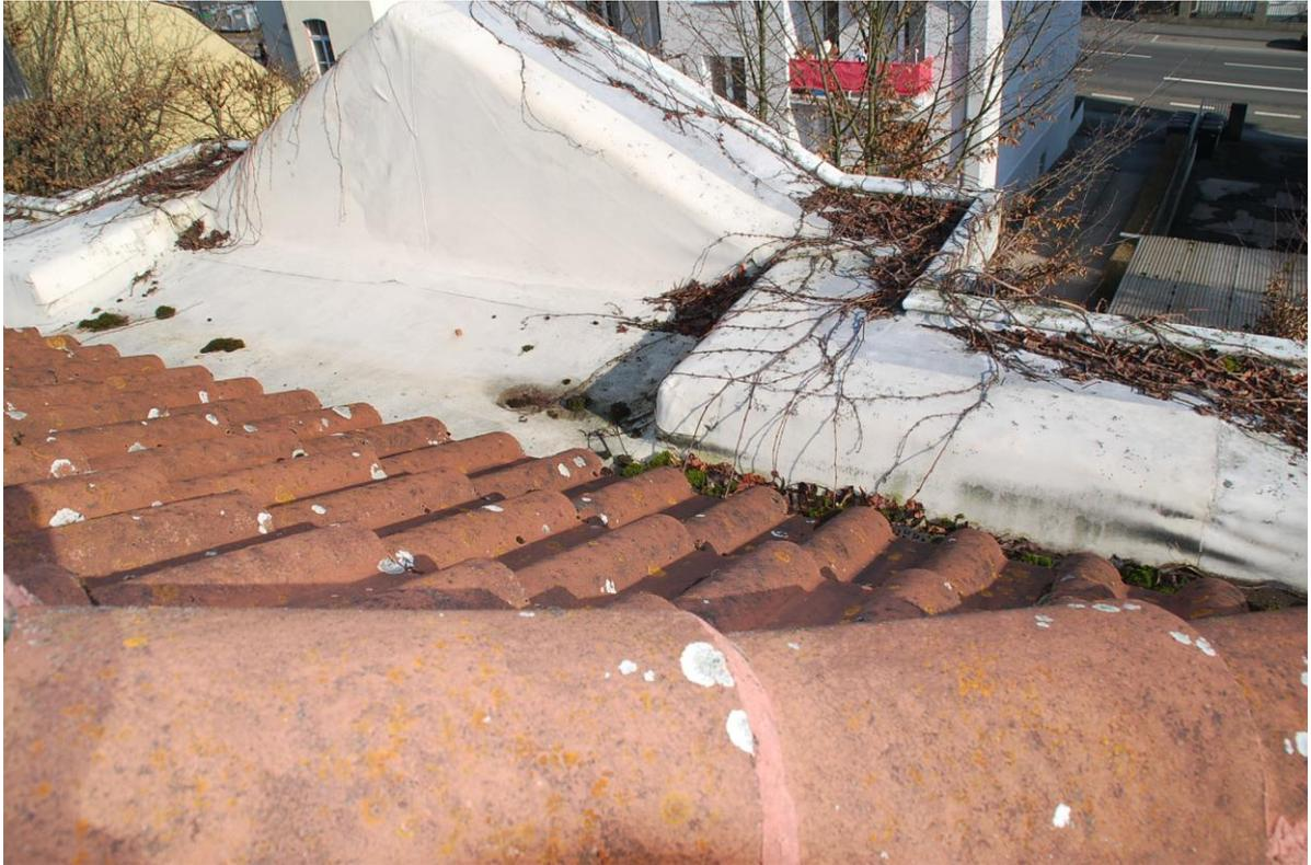
Detail Dachentwässerung über innenliegende Dachrinne
