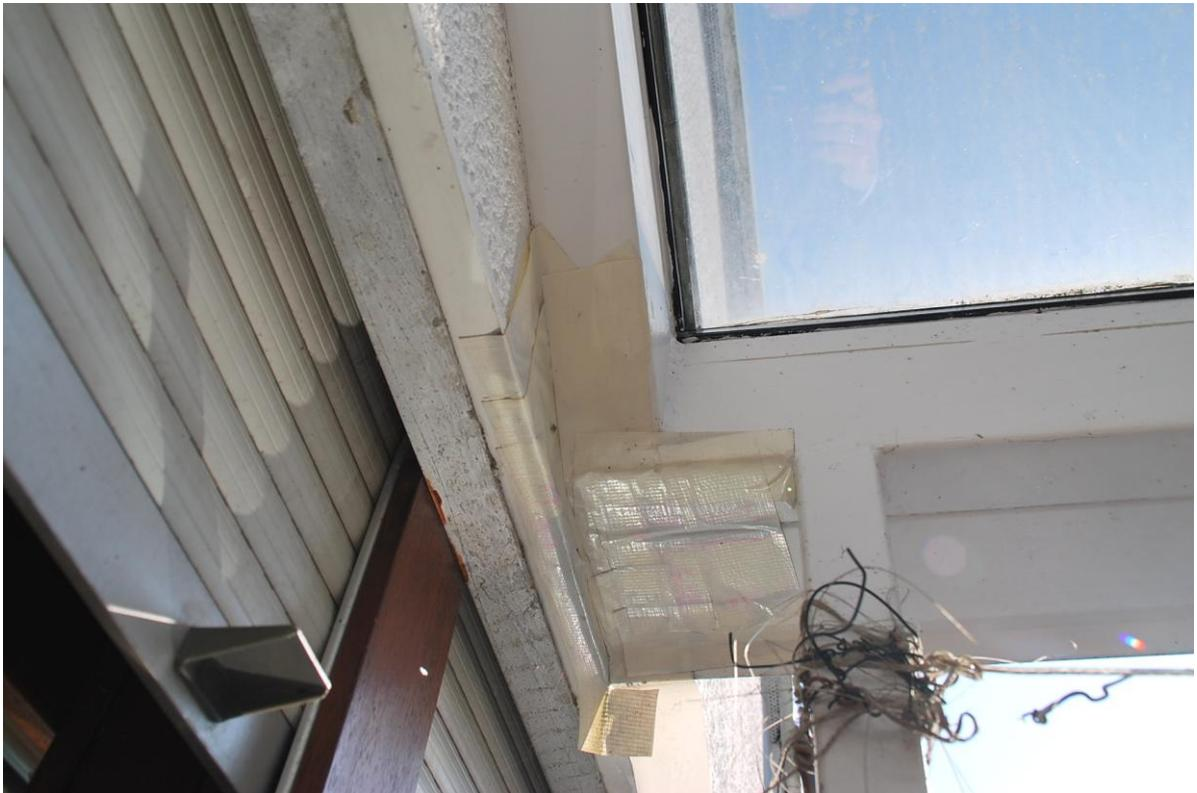
undichte Entwässerung Terrassendach
